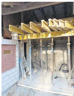
Die Anlage bekommt Konturen...
